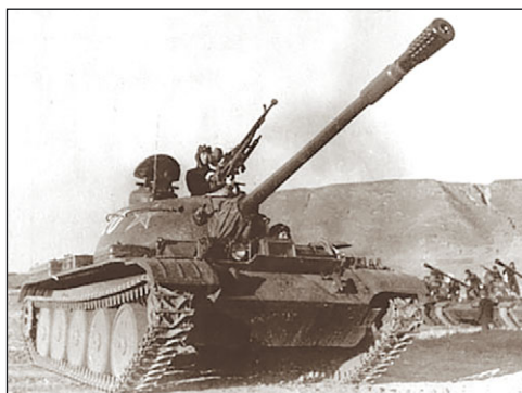
Прототип танка Type 62, вооруженный 76-мм орудием
