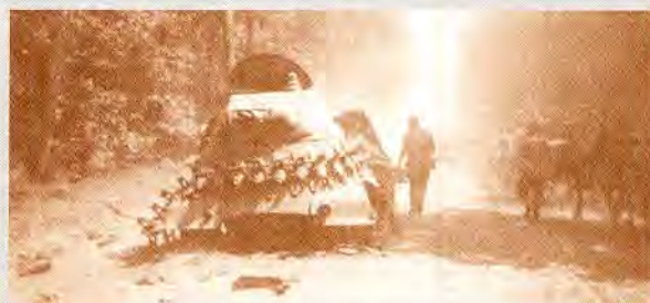
На этих фотографиях хорошо заметны гусеничные цепи «Оверолл», закрепленные на корпусе бронеавтомобиля БА-11.
