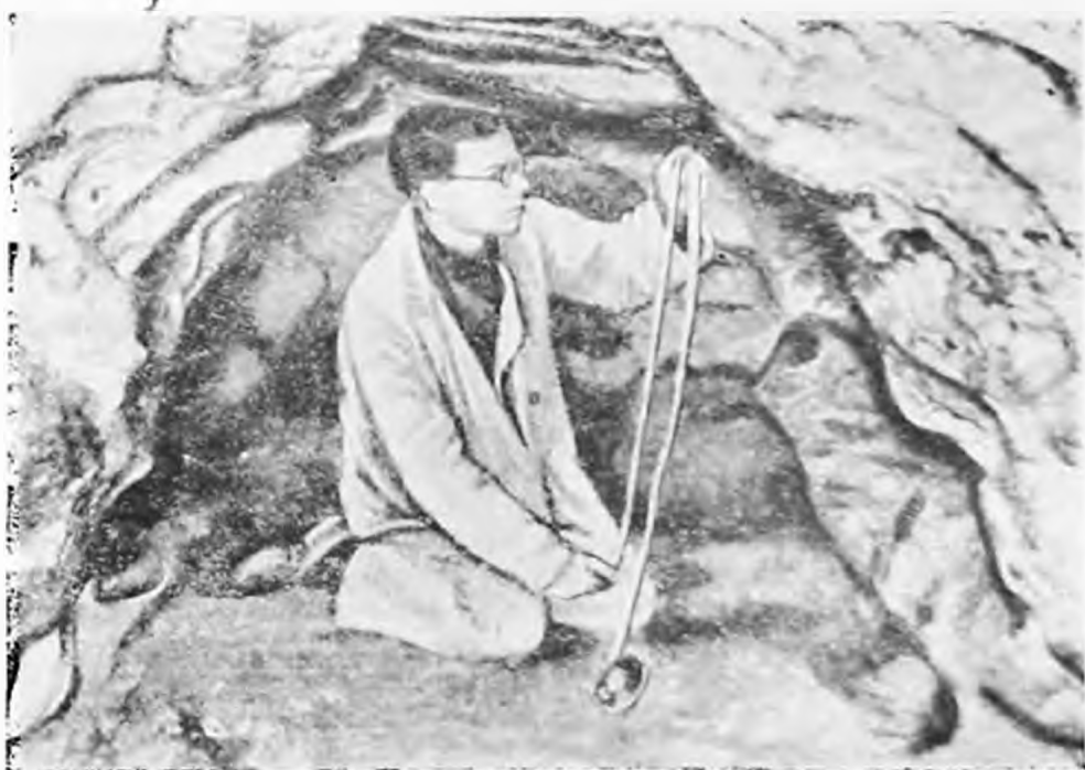
Рис. 10. Карстовая пещера в известняках на трассе метро.
