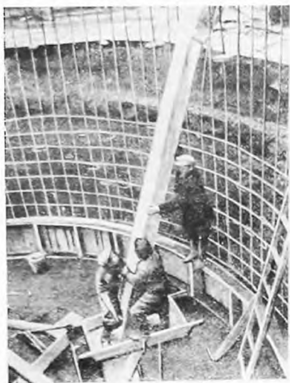
Рис. 13. Обделка стены котлована.
