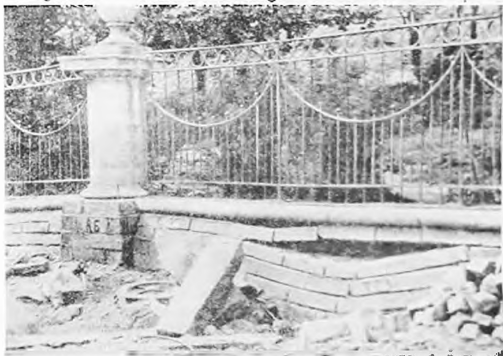
Рис. 12. Деформация на Волхонке (фундамент ограды здания Ленинской библиотеки).
