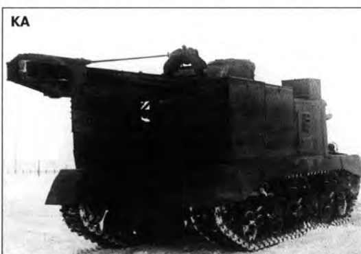
Ремонтно-эвакуационный танк M31 на базе M3 «Ли» на испытаниях в Кубинке. An M31 recovery vehicle based on the M3 Lee undergoes testing at Kubinka.
