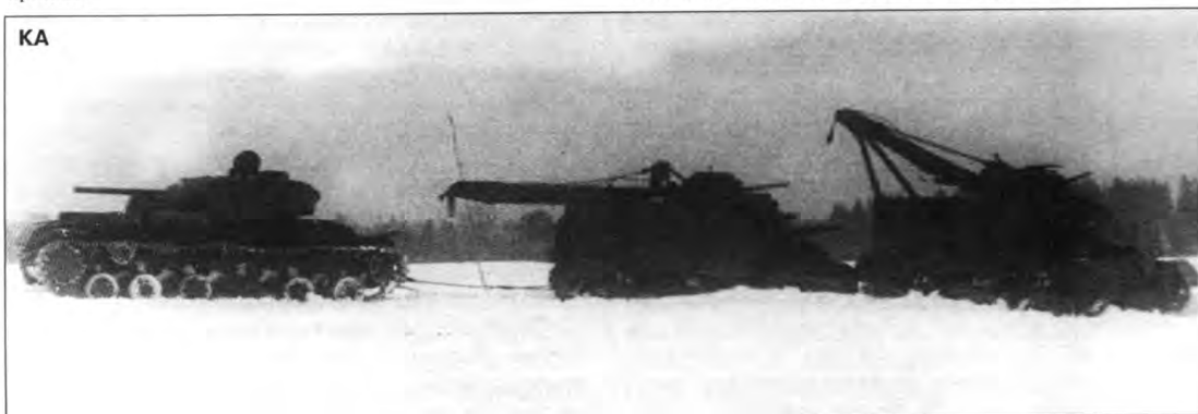
Танки T-2 (M31) в спарке буксируют тяжелый KV-1. Полигон НИБТ, зима 1942-43гг. T2 (M31) recovery tanks are paired up to tow a KV-1 heavy tank. NIBT Test Range, winter 1942-43.
